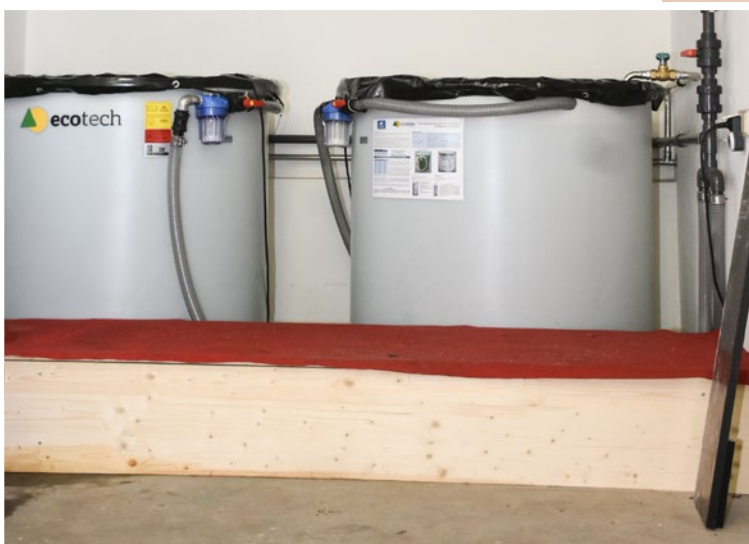
Das 6.000 Liter Solelager in Pörtschach wurde von Wassermeister Harald Korak unter Hilfe von weiteren Bauhofmitarbeitern in Eigenregie konzipiert, aufgebaut und installiert.
