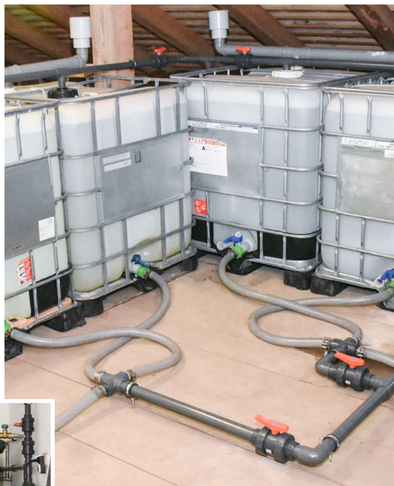
Das 6.000 Liter Solelager in Pörtschach wurde von Wassermeister Harald Korak unter Hilfe von weiteren Bauhofmitarbeitern in Eigenregie konzipiert, aufgebaut und installiert.
